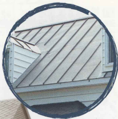
Toiture de remplacement, tôle pincée
